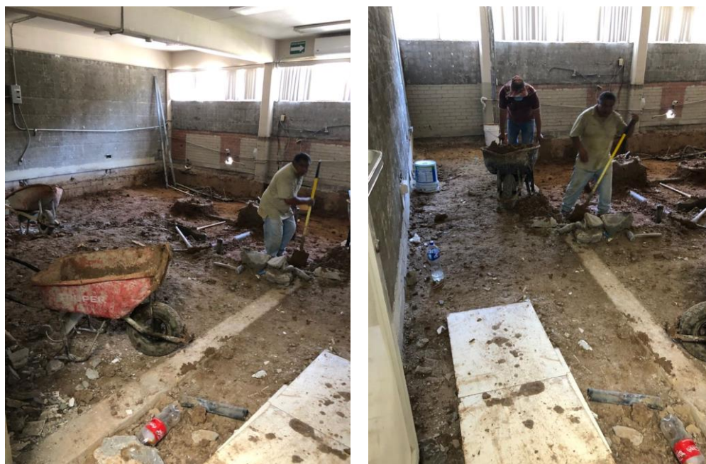
Imagen No. 27 y No. 28 Trabajos de remodelación de clínica G
